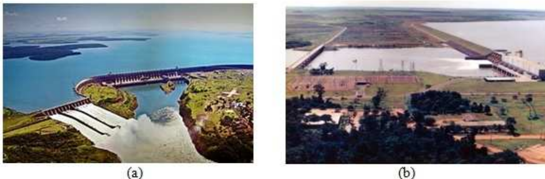
Figura II.5 – Imagem fotográfica da barragem da Usina de (a) Itaipu Binacional – Foz do Iguaçu – PR, e (b) Usina a fio d’água de Rosana-SP (divisa com Diamante do Norte – PR)
